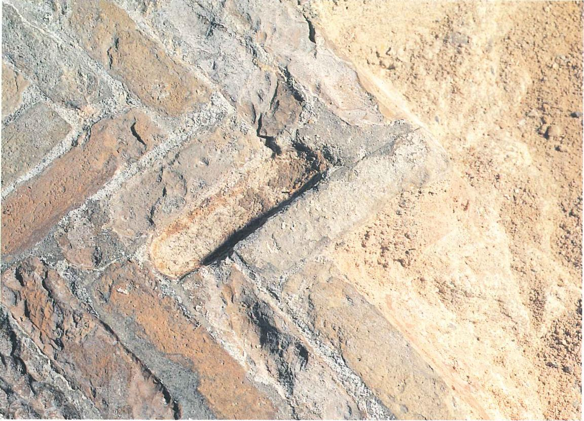
Detalle de un pavimento de *opus spicatum*. La cristalización de sales solubles provoca la descamación y disgregación de los elementos cerámicos.
