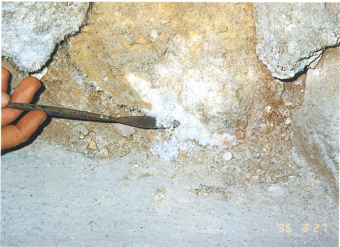
Cristalización de sales y disgregación de argamasa y material pétreo localizada en la parte baja de un muro en la zona donde está en contacto con un pavimento de hormigón.
